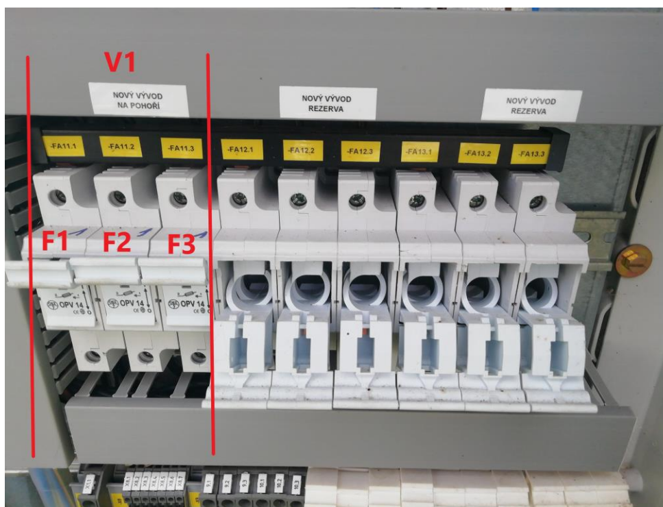
Obr. 3 Detail RVO-1 s vyznačenými fázemi pro každou větev
