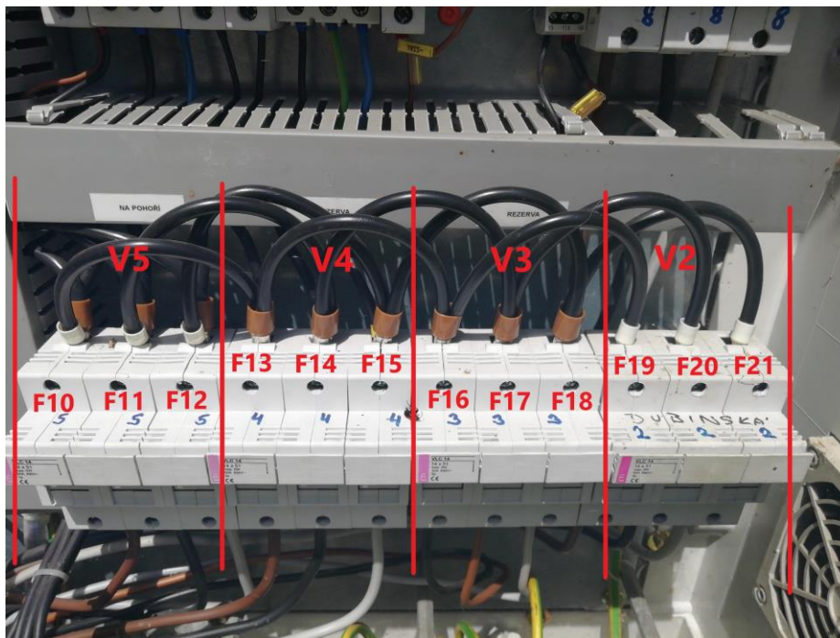
Obr. 10 Detail RVO-4 s vyznačenými fázemi pro každou větev
