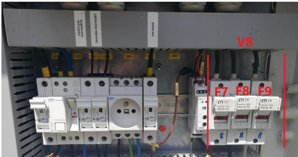
Obr. 12 Detail RVO-4 s vyznačenými fázemi pro každou větev
