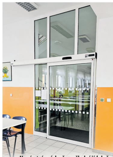
Nové otvírací dveře ve školní jídelně
