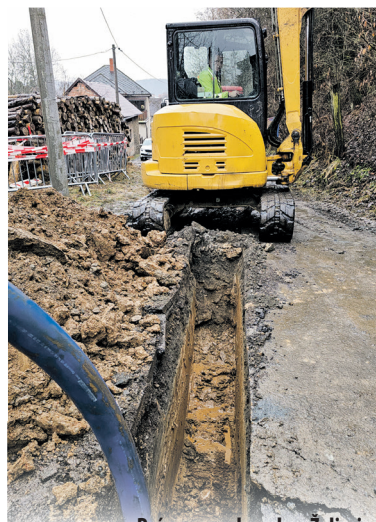
Práce na vodovodu v Želivci
