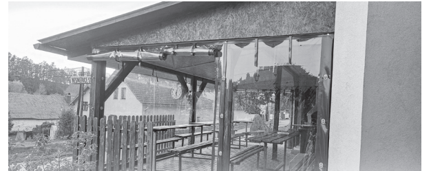
Opravená pergola u hasičárny v Nesměřích
