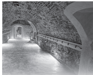
Opravené zámecké sklepení
