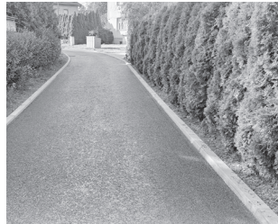
Horní ulice po výstavbě vodovodu a kanalizace
