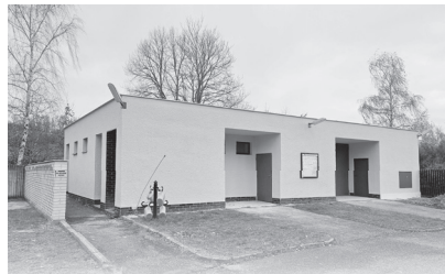
Opravená fasáda technického zázemí hřbitova
