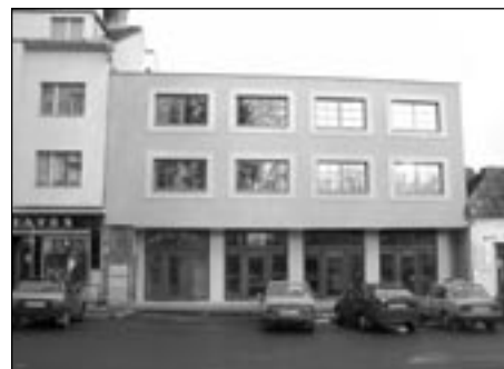
Rekonstrukce bývalého domu služeb (foto : MB)
