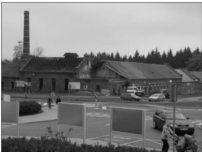
Začala oprava přední části Zručského dvora
