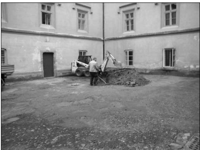
Technické služby provádí opravu dešťové kanalizace na nádvoří zámku
