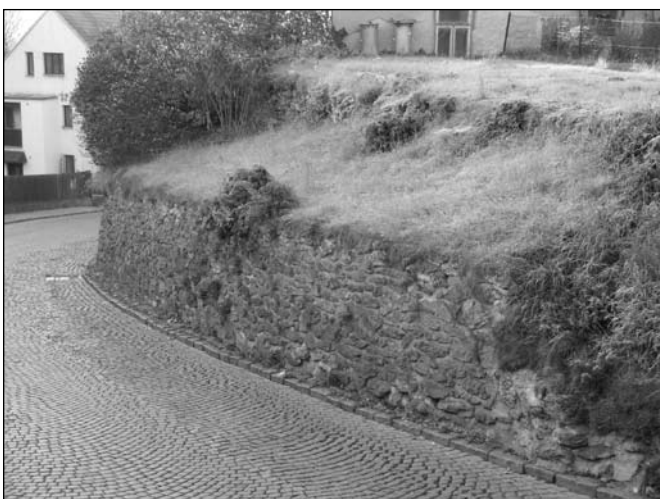
Krajský úřad zahájil projektové práce na opěrné zdi v zatáčce u hřbitova. V projektu půjde o posunutí opěrky a přesunutí chodníku na druhou stranu.
