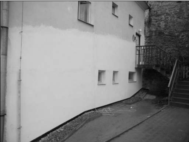
Částečná oprava fasády budovy MP
