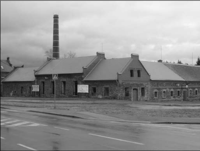
Opravená střecha bývalého lihovaru
