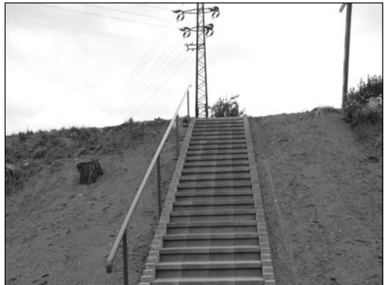
Schodiště u staré vodárny
