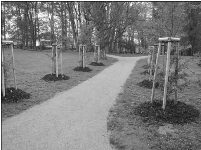
Mlatová cestička s novou výsadbou - Mlatové pěšinky budou kompletně dokončeny na přelomu května a června. Zbývá finální válcování a dokončení úpravy okolí. V závěrečné etapě byly vybudovány i v parčíku vedle pošty.
