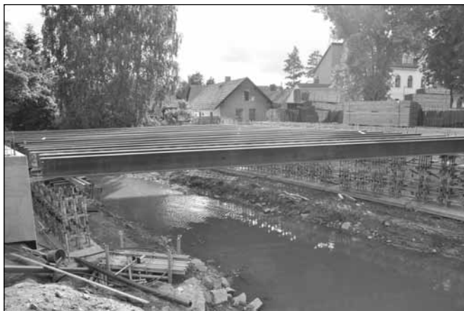
Nový most nad Ostrovským potokem se již rýsuje (foto Martin Beneš)
