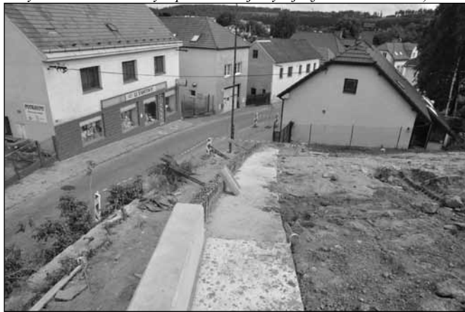
Nová opěrná zeď po navedení zeminy (foto Martin Beneš)
