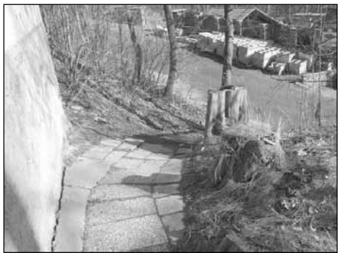
Zrušený vchod na hřbitov
