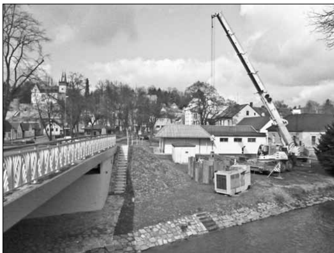
Výstavba kanalizace na náměstí
