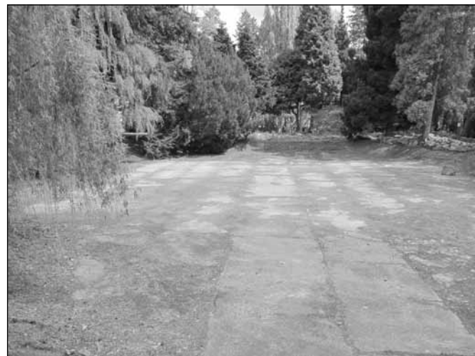
Jezírko ... V dubnu byl zadán projekt na rekonstrukci jezírka u altánu v zámeckém parku. Je potřeba vyprojektovat dno jezírka a jeho vypouštění. Po dokončení projektu budeme znát finanční nároky uvažované rekonstrukce. Naše Technické služby již ze dna odstranily rozpadající se beton a byla vyzkoušena vydatnost přítoku z Dubiny.
