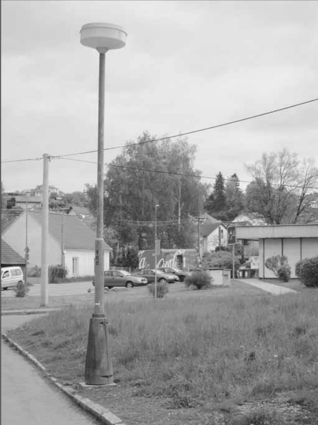
Další etapa rekonstrukce veřejného osvětlení začíná ... Výměny lamp včetně zemního vedení se v letošní etapě rekonstrukce veřejného osvětlení dočkají obyvatelé těchto ulic – Nábřeží, Nádražní (po nádraží), Nová, Příčná, Budovatelů, Družební, Ke Stadionu, Říční, M. Jana Husi, Zahradní, Slunný vrch, Spojovací. Zhotovitelem akce je kolínská firma Raisa. Na fotce přidaná lampa za benzínkou.
