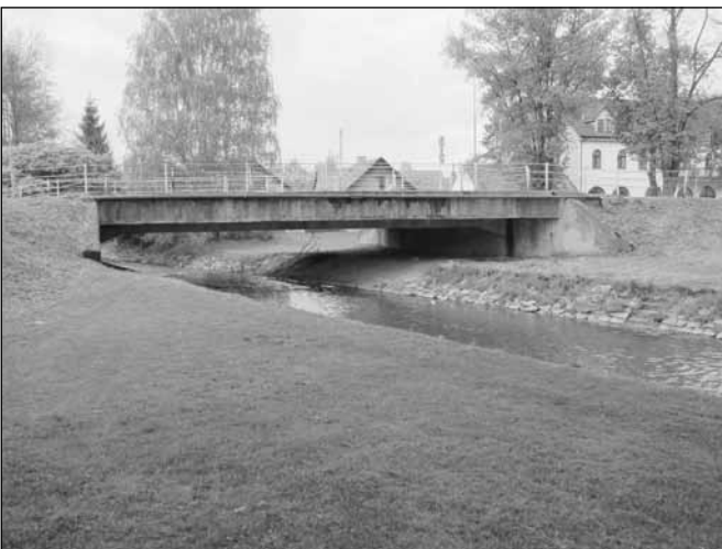
Most a opěrka ... V měsíci květnu dojde k zahájení dvou očekávaných akcí – stavbě nového mostu přes Ostrovský potok a rozšíření zatáčky pod starým hřbitovem (vznikne nový, dva metry široký, chodník na vnitřní straně zatáčky). Akce bude zahájena demolicí budovy nad zatáčkou (Kalambacher) a výstavbou provizorního mostu za železářstvím. Prosím občany o trpělivost – budou instalovány dva semaforey a pro auta bude uzavřen mostek u restaurace Na Ostrově. Obě akce by měly být ukončeny do konce září.
