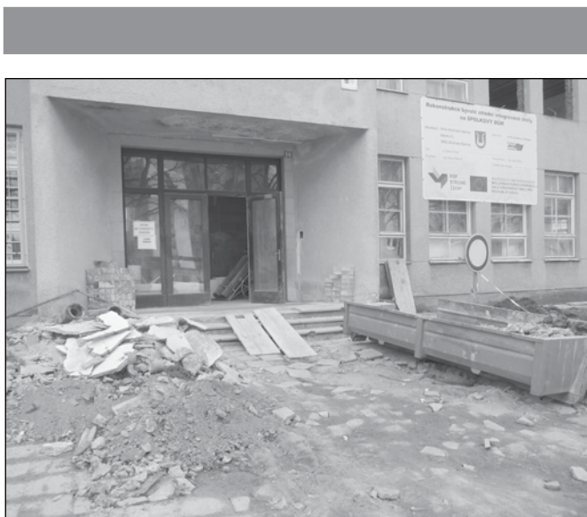
Spolkový dům ... Dobrým tempem pokračují práce na spolkovém domě. Byla dokončena výměna oken, postaveny nové příčky a probíhá práce na rozvodech vody, kanalizace a topení uvnitř budovy.
