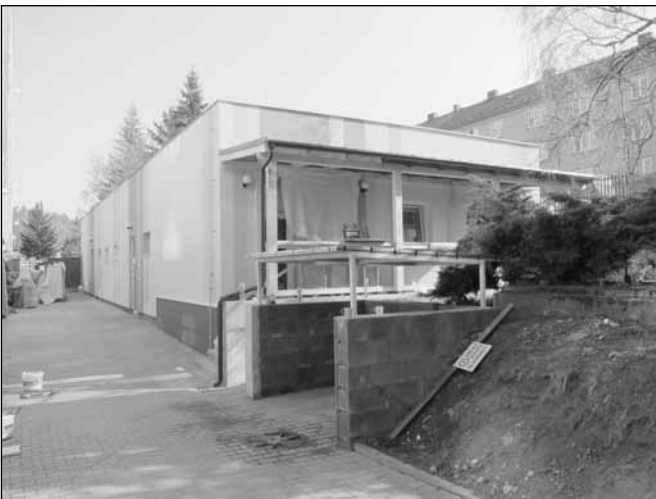
Kotelna – centrum sociálních služeb ... Byla dokončena rekonstrukce nevyužívaného objektu kotelny Na Výsluní na centrum sociálních služeb. Slavnostní otevření pro veřejnost proběhne 2. června od 16.00 do 19.00. Náklady na rekonstrukci dosáhly 9,5 mil. korun, ze kterých EU zaplatila 92,5 %.
