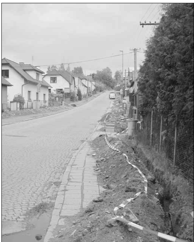
ČEZ dává v ulici Dubinská kabely do země.
