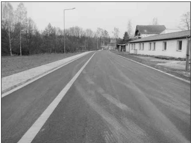
Průmyslová ulice ... Rekonstrukce Průmyslové ulice byla dokončena včetně nového chodníku, otočky pro kamiony a parkovacích míst. Stavba přišla včetně přeložky elektrického vedení na 7,5 mil. korun, ze kterých EU zaplatila 65 %.
