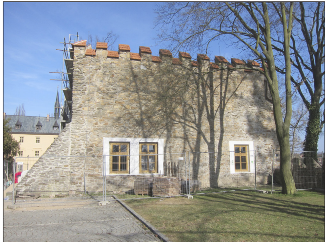
Špýchar v rekonstrukci
