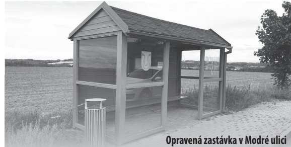
Opravená zastávka v Modré ulici
