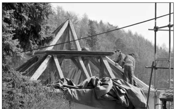
Oprava střechy bývalé márníce za kostelem
