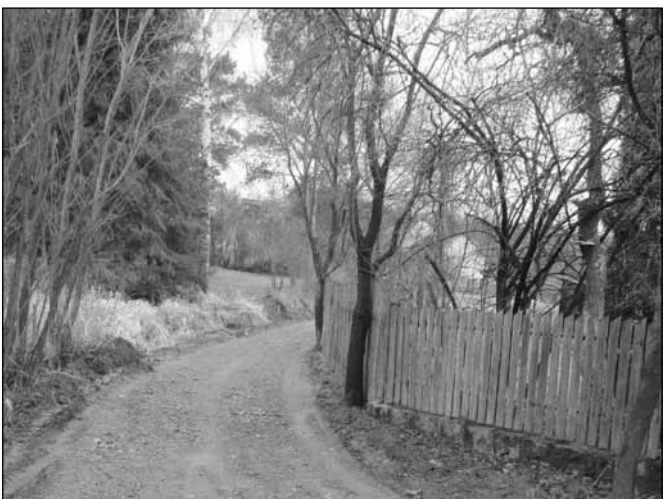
Cesta Domahoř - Povodí Vltavy opravilo část cesty v osadě Domahoř. Na cestu byl naveden štěrk.
