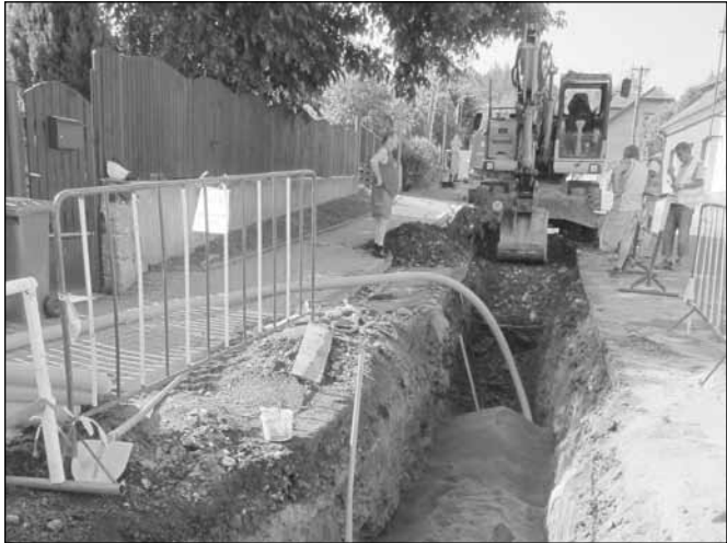
Práce na kanalizaci v plném proudu - Práce na zhotovení kanalizace ve Staré Zruč probíhají v Dubinské, Vlašimské a Malostranské ulici. V dalších lokalitách probíhá výstavba kanalizačních přípojek. (Mgr. Martin Hujer)
