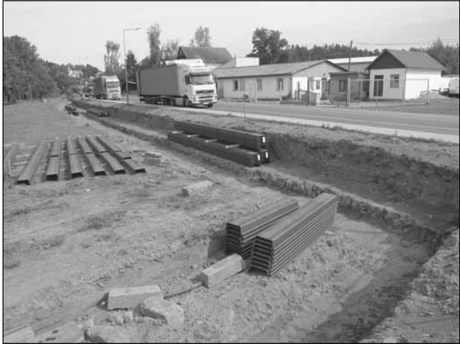
Zruč nad Sázavou bude chráněna před stoletou vodou - Výstavbu protipovodňových opatření ve Zruč nad Sázavou aktuálně probíhá v Průmyslové ulici a podél Ostrovského potoka. Plánované ukončení se předpokládá v červnu roku 2013. (Mgr. Martin Hujer)
