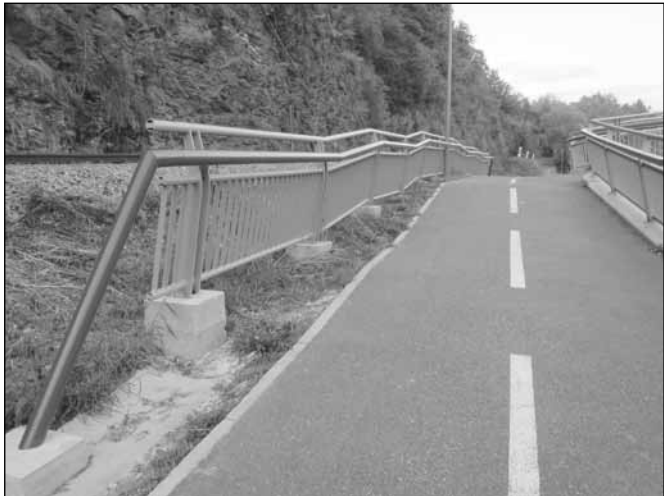
Zábradlí mezi cyklostezkou a tratí - U lávky ke stadionu bylo nainstalováno nové zábradlí mezi cyklostezkou a železniční tratí. Nahradilo plot, který byl často poškozen. Zábradlí je ve stejného tvaru a provedení jako na lávce. (Mgr. Martin Hujer)
