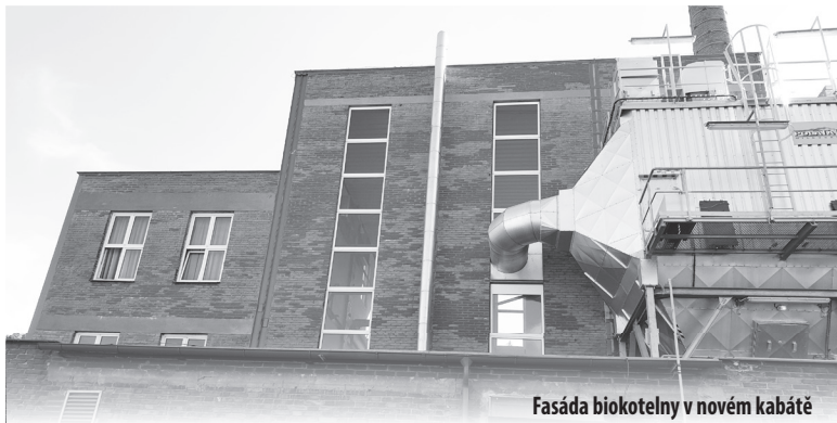
Fasáda biokotelny v novém kabátě
