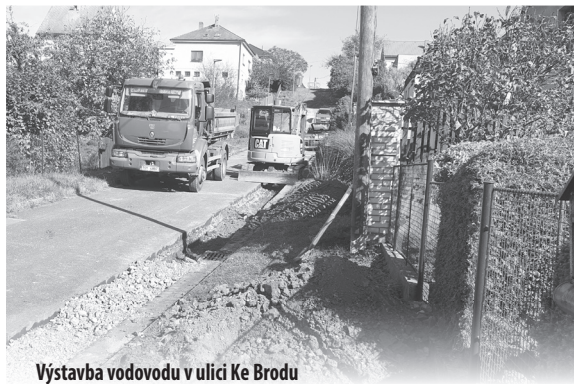
Výstavba vodovodu v ulici Ke Brodu
