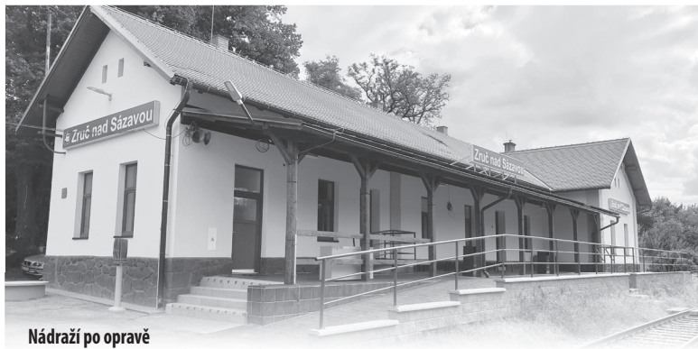
Nádraží po opravě
