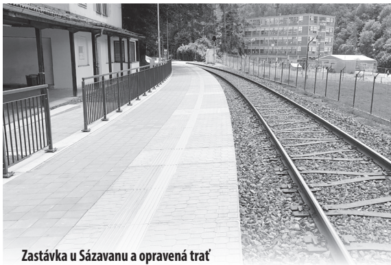
Zastávka u Sázavou a opravená trať
