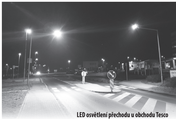
LED osvětlení přechodu u obchodu Tesco
