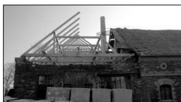
Foto Lenka Říhová: Budování krovů na lihovaru ve Zručském dvoře
