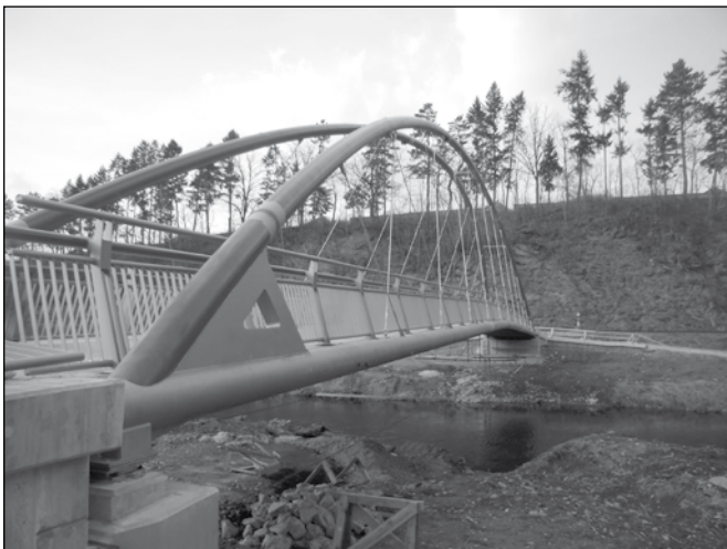
Foto Martin Hujer: Most již má zábradlí
