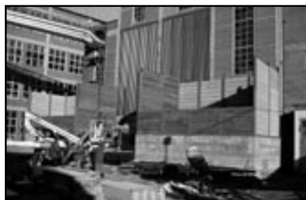
Práce na nové biokotelně
