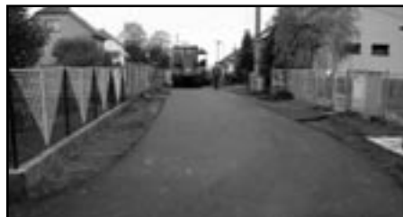
Nový asfaltový koberec v ulici Lomená
