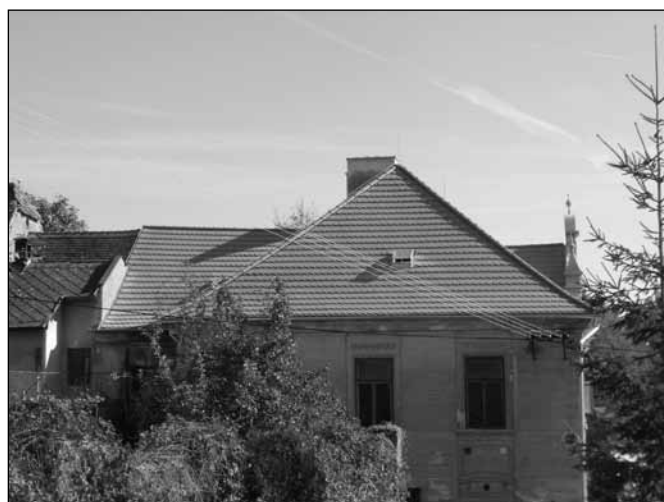
Foto: Nová střecha v bývalé Škole Pod Farou
