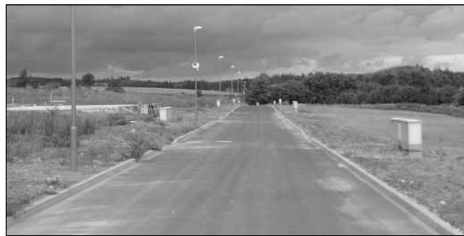
Foto: Lokalita Nad Ovčínem - Připraveno pro výstavbu 26 rodinných domů
