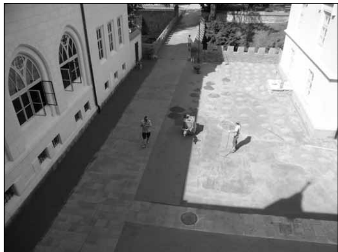
Foto: Práce na dokončení nádvoří
