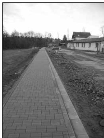
Foto: Rekonstrukce Průmyslové ulice
