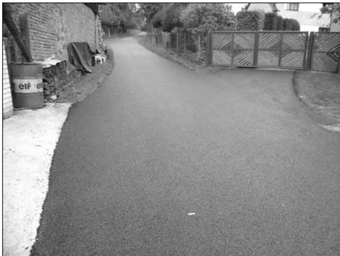
Foto: Asfaltování v Želivci
