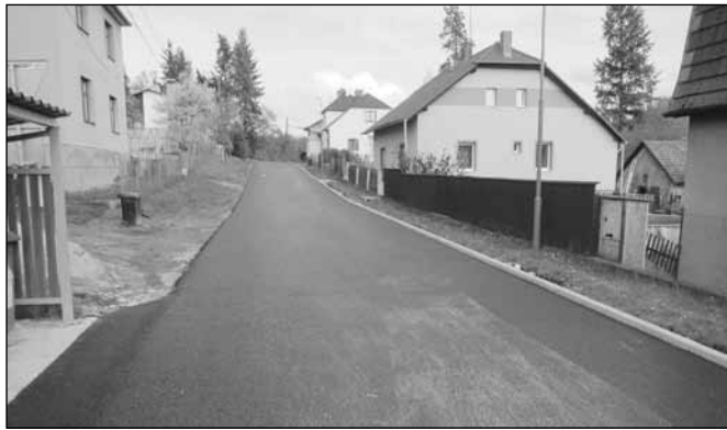
Ulice M. J. Husi s novým povrchem a asfaltování v ulici Na Úvoze
