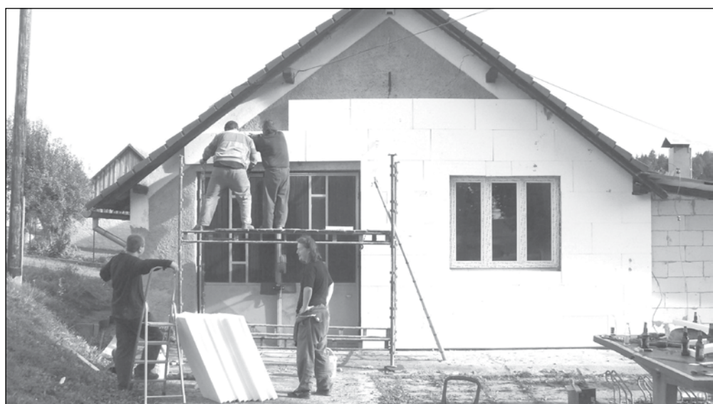
Nesměřická hasičárna - Hasiči v Nesměřicích dali nový kabát hasičárně. Budovu zateplili, natřeli penetrací a vyměnili staré okno za nové
