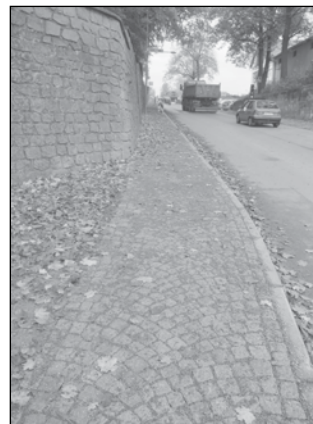
Chodník podél parkové zdi - Penny Market zaplatil rekonstrukci chodníku podél parkové zdi a před Zručským dvorem. Práci provádí firma Evos Hydro z Ledče nad Sázavou. V historické části u parku je již z poloviny položena žulová dlažba. Před Zručským dvorem bude chodník ze zámkové dlažby. (Mgr. Martin Hujer)
