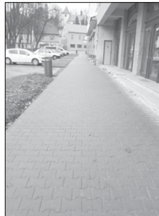
Chodníky na náměstí - Technické služby ve spolupráci s firmou Sates Čechy (zajišťují pokládku) dokončily rekonstrukci části chodníků na náměstí MUDr. Svobody. Letité betony a malé dlaždice nahradila žulová dlažba a zámkovka. (Mgr. Martin Hujer)
