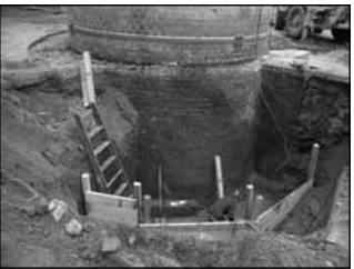
Foto: Oprava komínu v areálu Sázavanu
