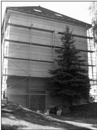
Foto: Zateplení štitových stěn
