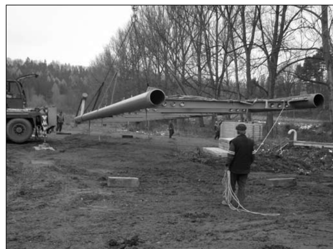
20.11.2007 byl dovezen nový most přes Sázavu u stadionu
