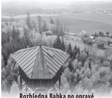
Rozhledna Babka po opravě
