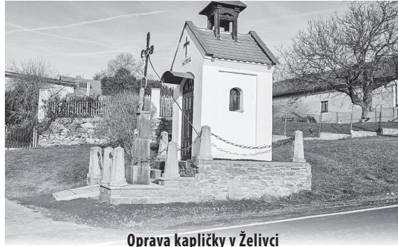
Oprava kapličky v Želivci
