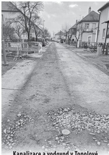
Kanalizace a vodovod v Topolové
