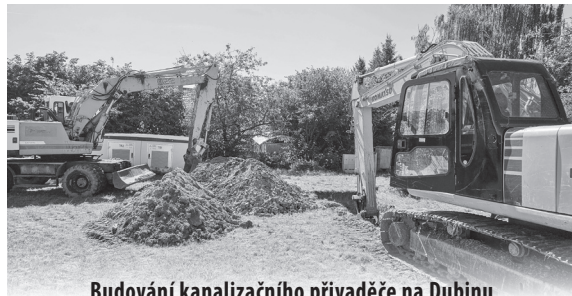
Budování kanalizačního přivaděče na Dubinu
