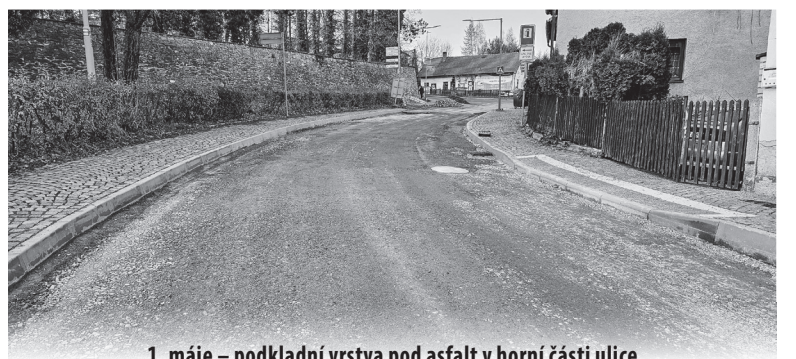
1. máje – podkladní vrstva pod asfalt v horní části ulice
