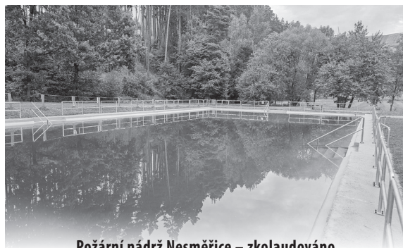
Požární nádrž Nesměřice – zkolaudováno
