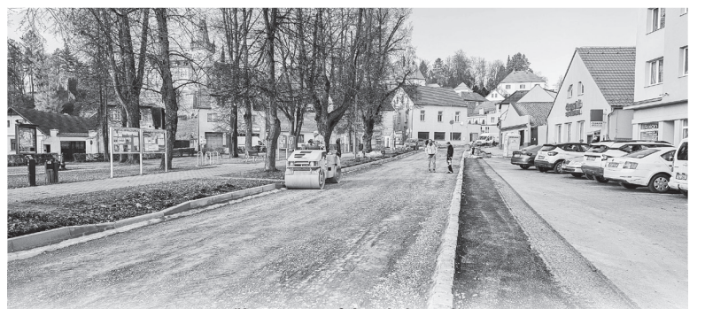
Příprava na asfaltování 1. máje
