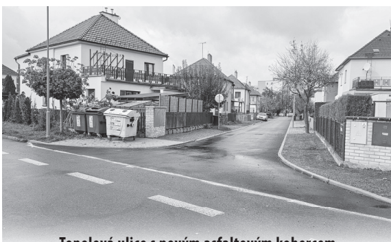
Topolová ulice s novým asfaltovým kobercem
