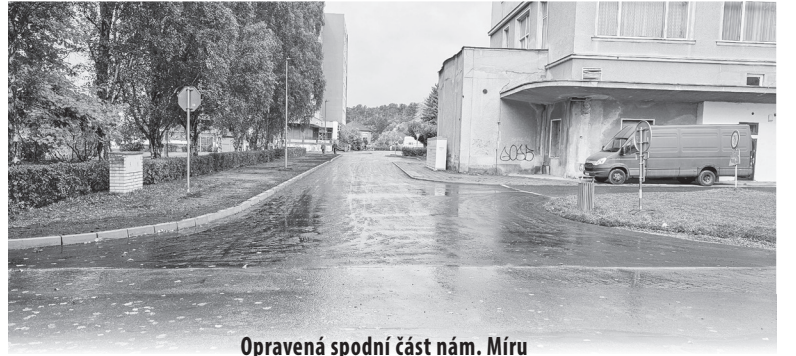
Opravená spodní část nám. Míru
