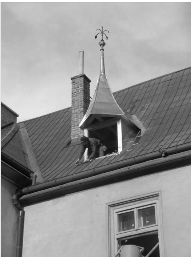
Práce na střeše zámku
