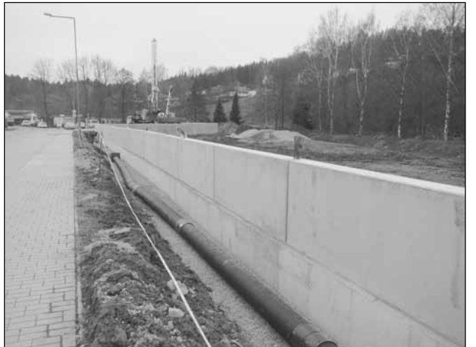
Protipovodňová opatření - Výstavba protipovodňové ochrany v Průmyslové ulici. (Mgr. Martin Hujer)
