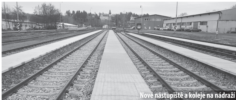
Nové nástupiště a koleje na nádraží
