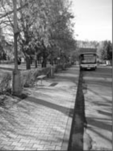
Opravený chodník v ulici T. Bati
