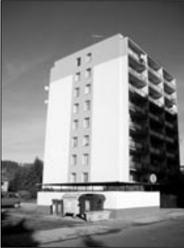
Zateplené paneláky v Poštovní
