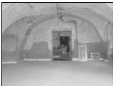
Pohled do budoucího infocentra
