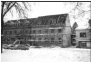
Rozestavěný objekt bývalé restaurace U Kuklů
