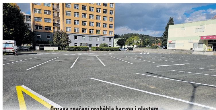
Oprava značení proběhla barvou i plastem
