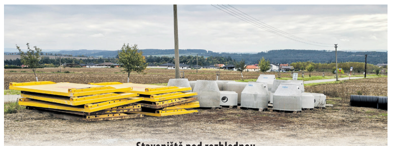
Staveniště pod rozhlednou
