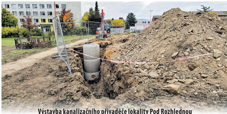
Výstavba kanalizačního přivaděče lokality Pod Rozhlednou
