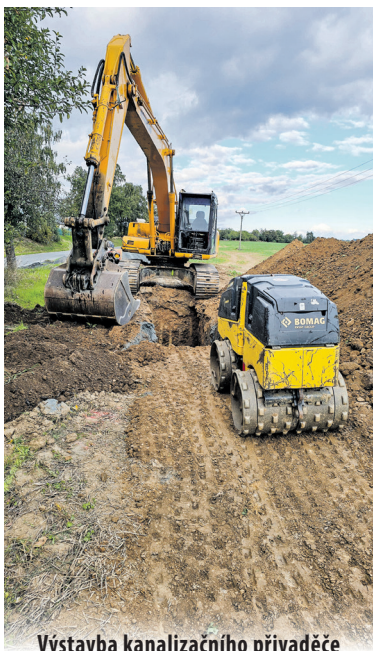
Poslední část výstavby kanalizace v ulici Pod Vysílačem
