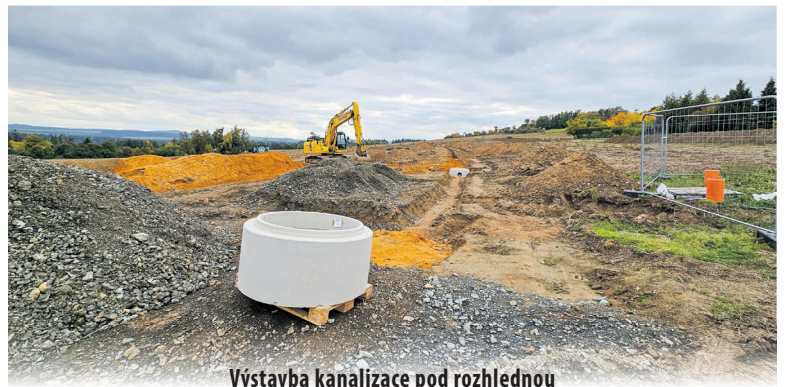
Výstavba kanalizace pod rozhlednou
