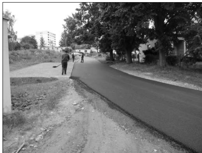
Asfaltování u garáží v Pardidubu
