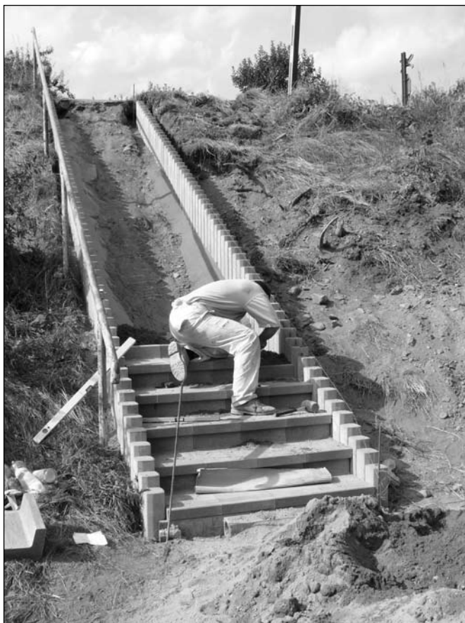
Foto Eda Janovský: Oprava schodů u staré vodárny
