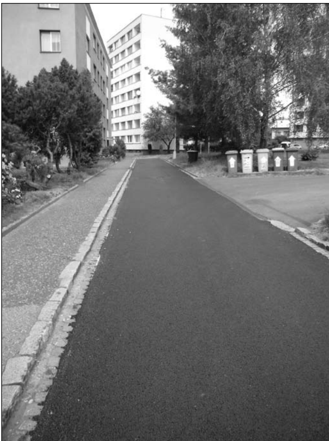
Nový asfaltový koberec v Družstevní ulici
