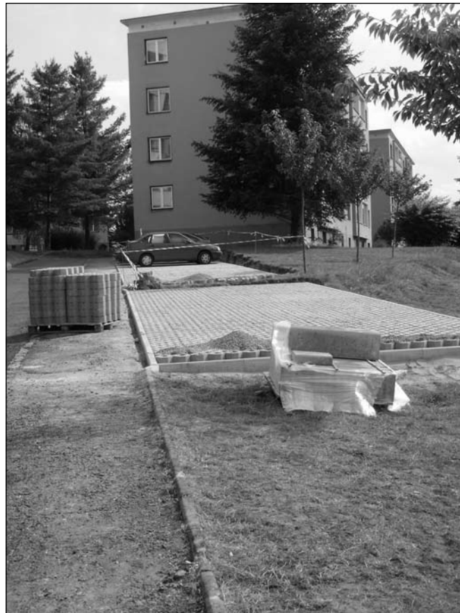
Výstavba parkoviště v Družstevní ulici
