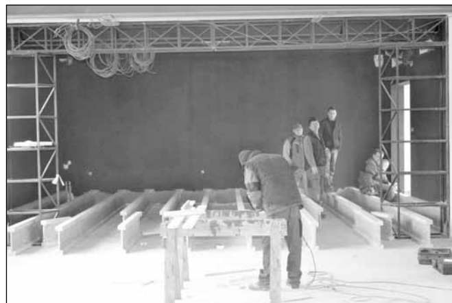
Foto: Tesařské práce - pódium sálu
