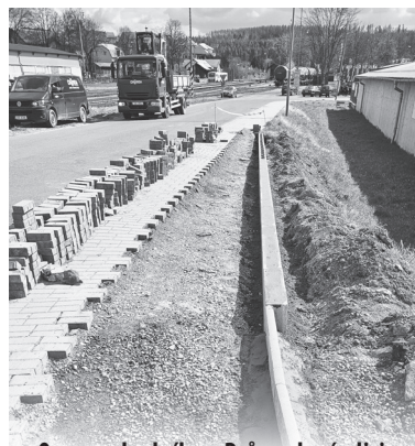
Oprava chodníku v Průmyslové ulici
