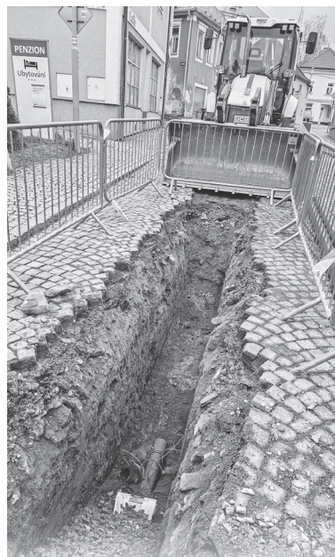
Pokládka vodovodu v ulici 1.máje
