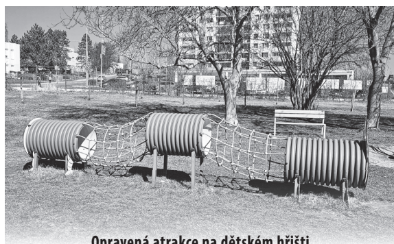
Opravená atrakce na dětském hřišti
