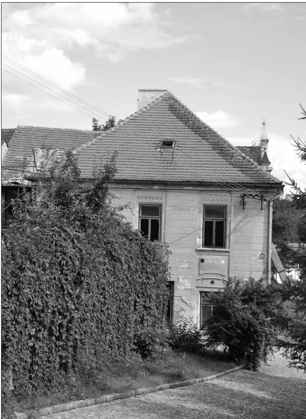
Nová střecha školy Pod Farou ... Po prázdninách začnou práce na rekonstrukci střechy a stropu školy Pod Farou. Investice si vyžádá přes 2 mil. korun.
