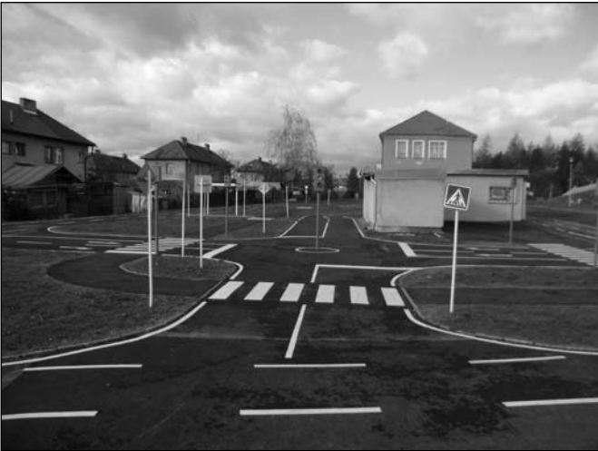
Foto: Dopravní hřiště po rekonstrukci
