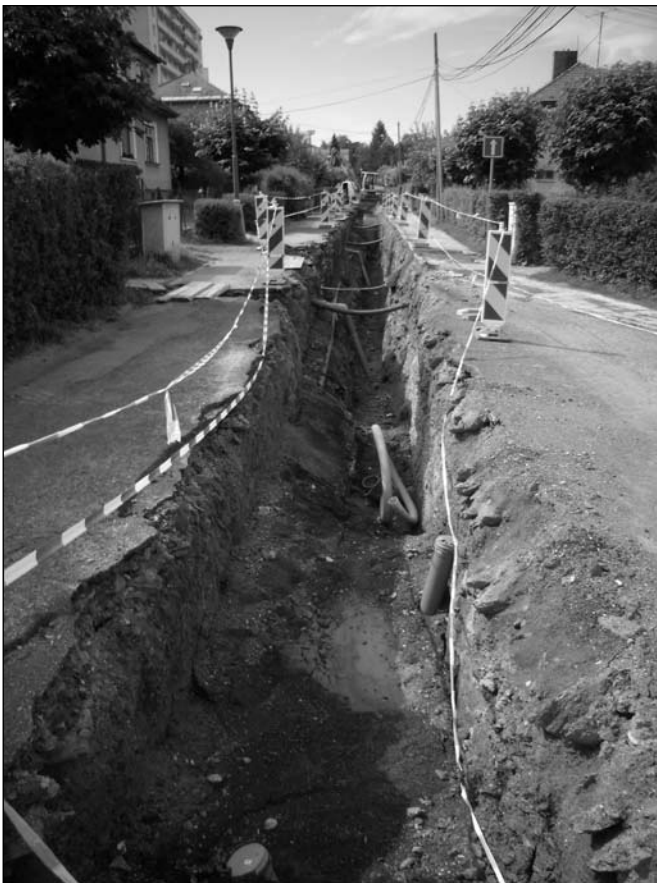
Foto: Rekonstrukce kanalizace a vodovodu v Revoluční ulici
