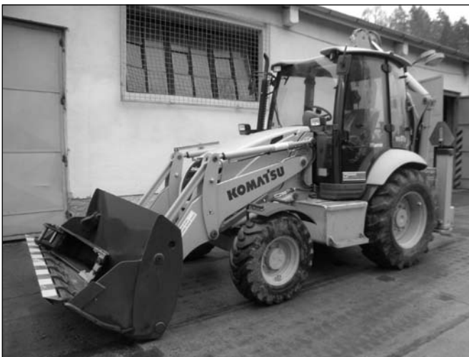
Foto: Rekonstrukce kanalizace a vodovodu v Revoluční ulici
