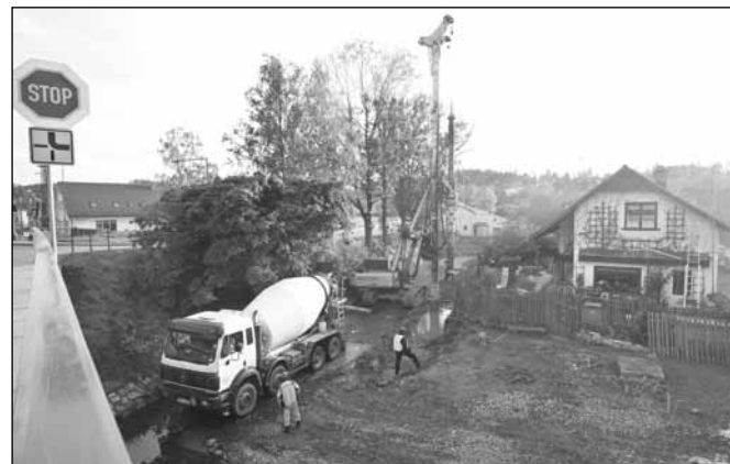
Stavba protipovodňových opatření (foto Lenka Říhová)
