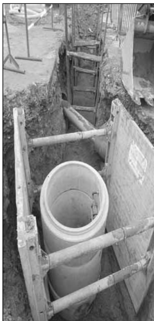
Budování kanalizační šachty v Kutnohorské ulici (Mgr. Martin Hujer)
