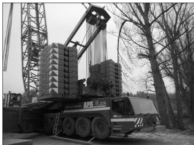
Martin Hujer: Jeřáb na usazení lávky přes řeku
