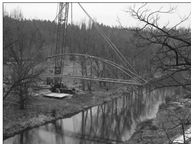
Vladimír Vyšohlíd: Usazování lávky přes řeku Sázavu
