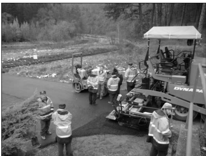
Asfaltování u čističky
