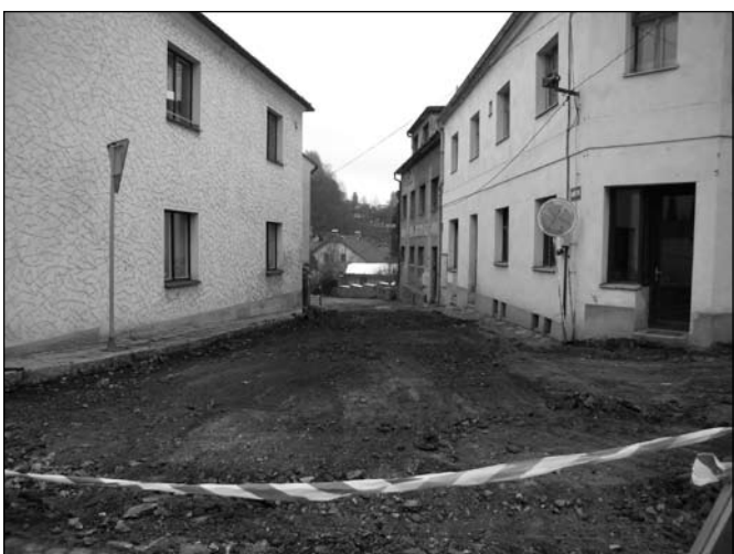
Horní část ulice Nábřežní čeká na nový asfalt
