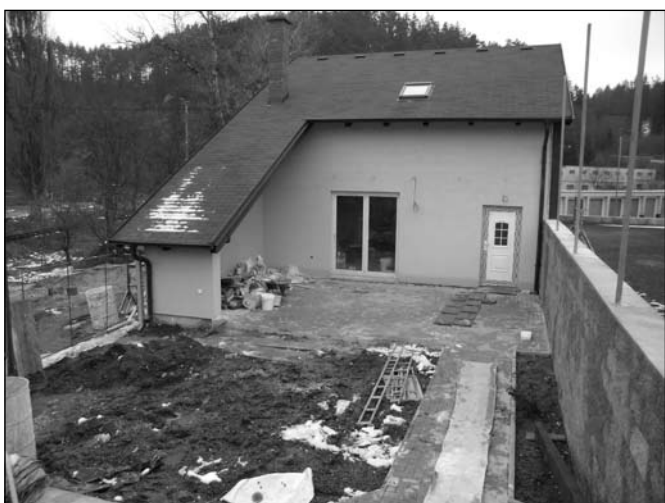
Zázemí nového víceúčelového hřiště u tenisových kurtů
