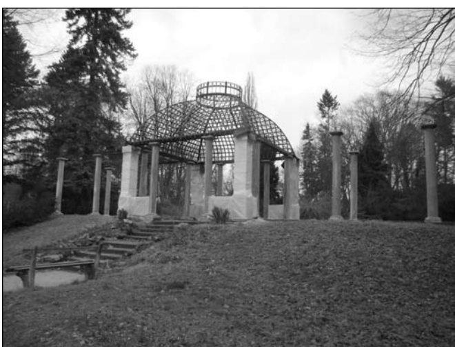
Altánek - 1. etapa oprav - zbývá osadit dřevěné prvky
