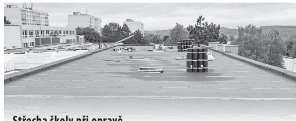
Střecha školy při opravě
