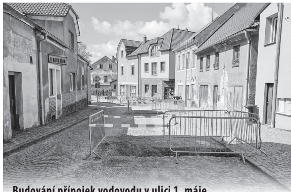
Budování přípojek vodovodu v ulici 1. máje
