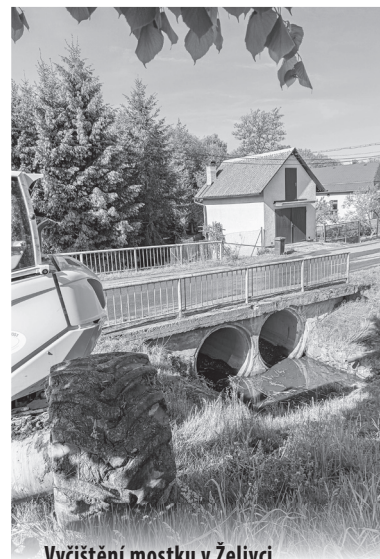
Vyčištění mostku v Želivci
