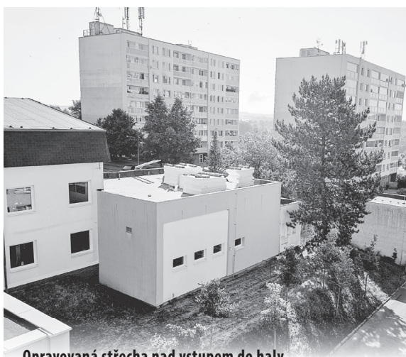
Opravovaná střecha nad vstupem do haly
