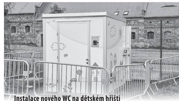
Instalace nového WC na dětském hřišti
