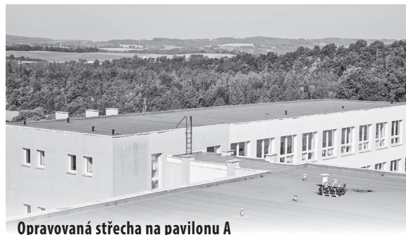
Opravovaná střecha na pavilonu A
