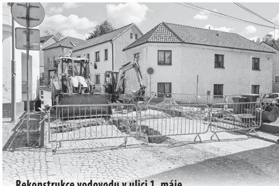
Rekonstrukce vodovodu v ulici 1. máje
