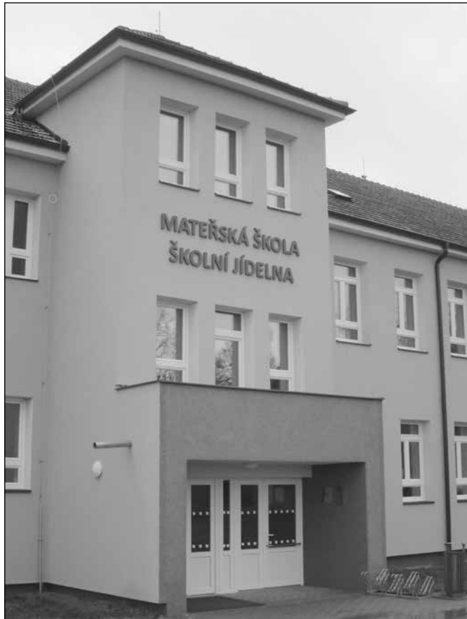
Školní jídelna po zateplení
