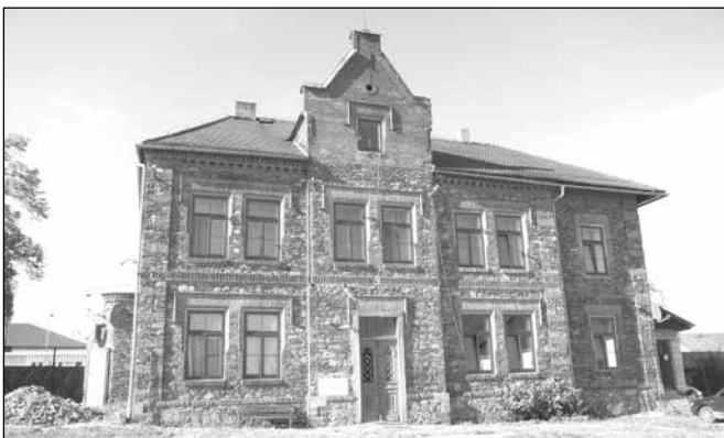
Vyměněná okna ve Zručském dvoře
