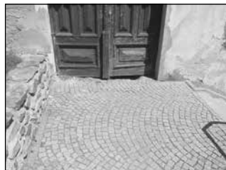
Dlažba po opravě
