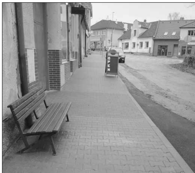
Chodník po rekonstrukci na náměstí MUDr. Svobody
