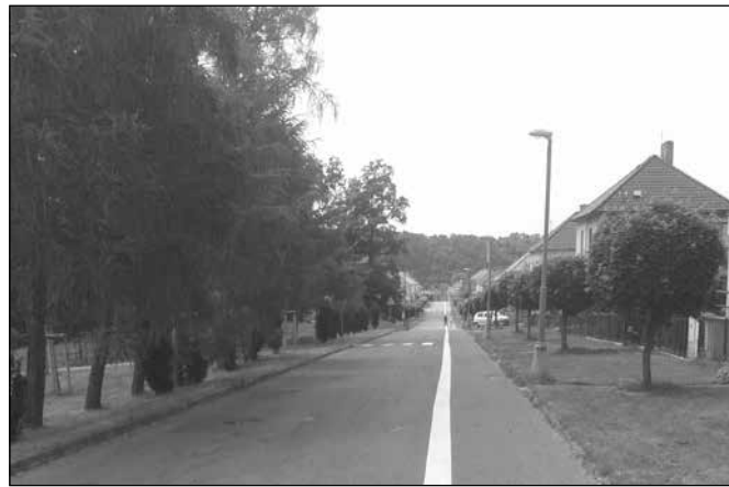
Obnovená čára vymezující chodník v Okružní ulici
