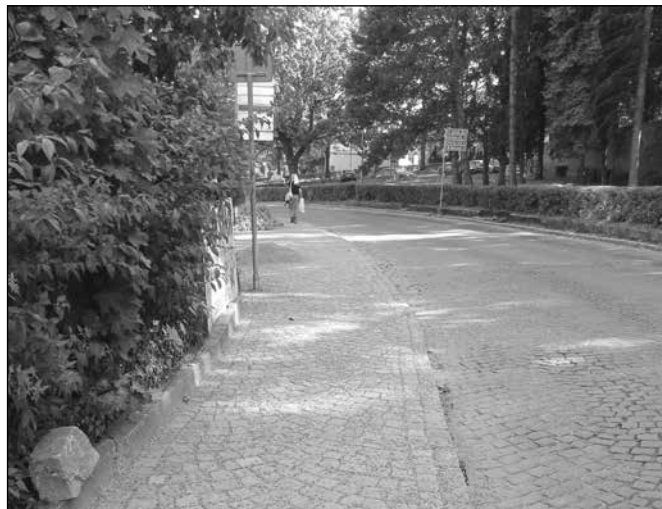
Rekonstrukce chodníku v ulici 1. máje
