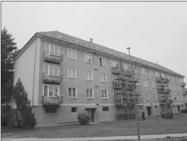
Oprava střechy a balkonů v Průběžné ulici
