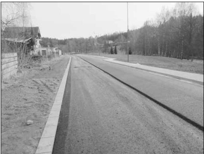
Asfaltování v Průmyslové ulici
