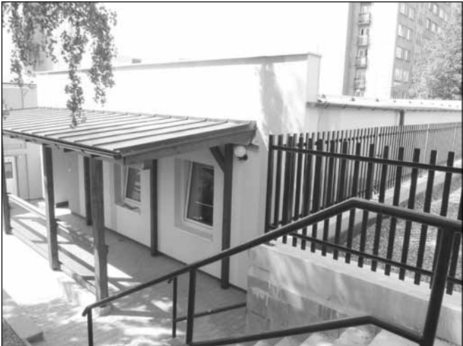
Kotelna - centrum sociálních služeb
