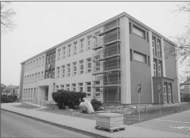
Dokončování fasády u Spolkového domu (foto Martin Hujer)
