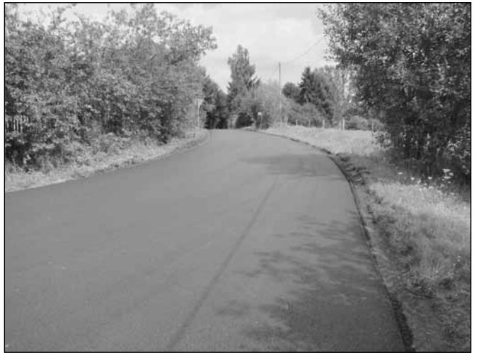
Nový asfaltový koberec u Želivce
