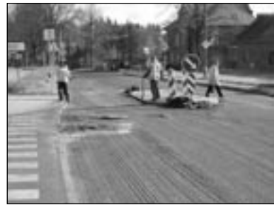
Poslední úpravy před asfaltováním
