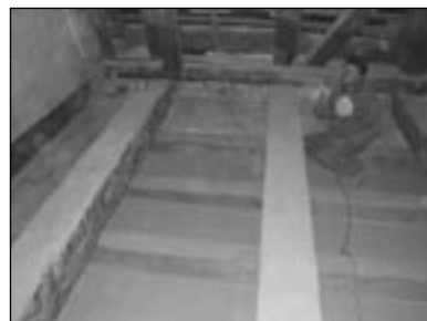
Odkryté trámy na stropu
