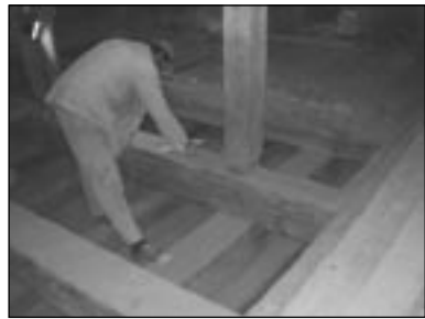
Opravy a čištění trámů v podlaze
