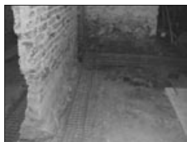
Budoucí větrací kanálky v podlaze
