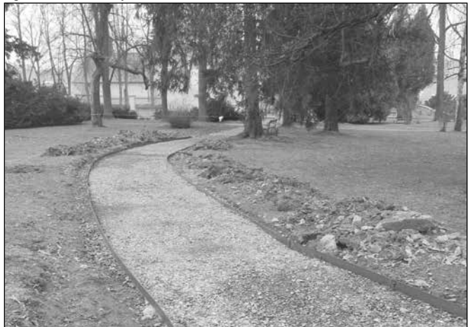
Mlatové pěšinky - Práce na pěšinkách v parku je již ve druhé polovině. Budou zřízeny i v lesoparku a obnoveny v parčíku za hotelem. Na šterkové lože ohraničené svařenou pásovinou se položí mlatový povrch.
