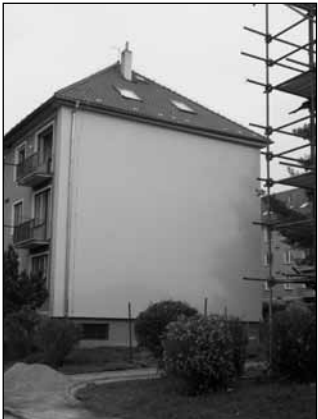
Foto: Částečné zateplování městských bytů
