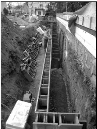
Foto: Opěrná zeď u kotelny Na Výsluní
