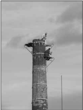
Foto: Demolice komínu ve Zručském dvoře (havarijní stav)
