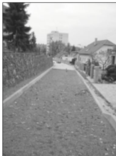
Ve Vyhliďkové ulici se provádí pokládka zámkové dlažby
